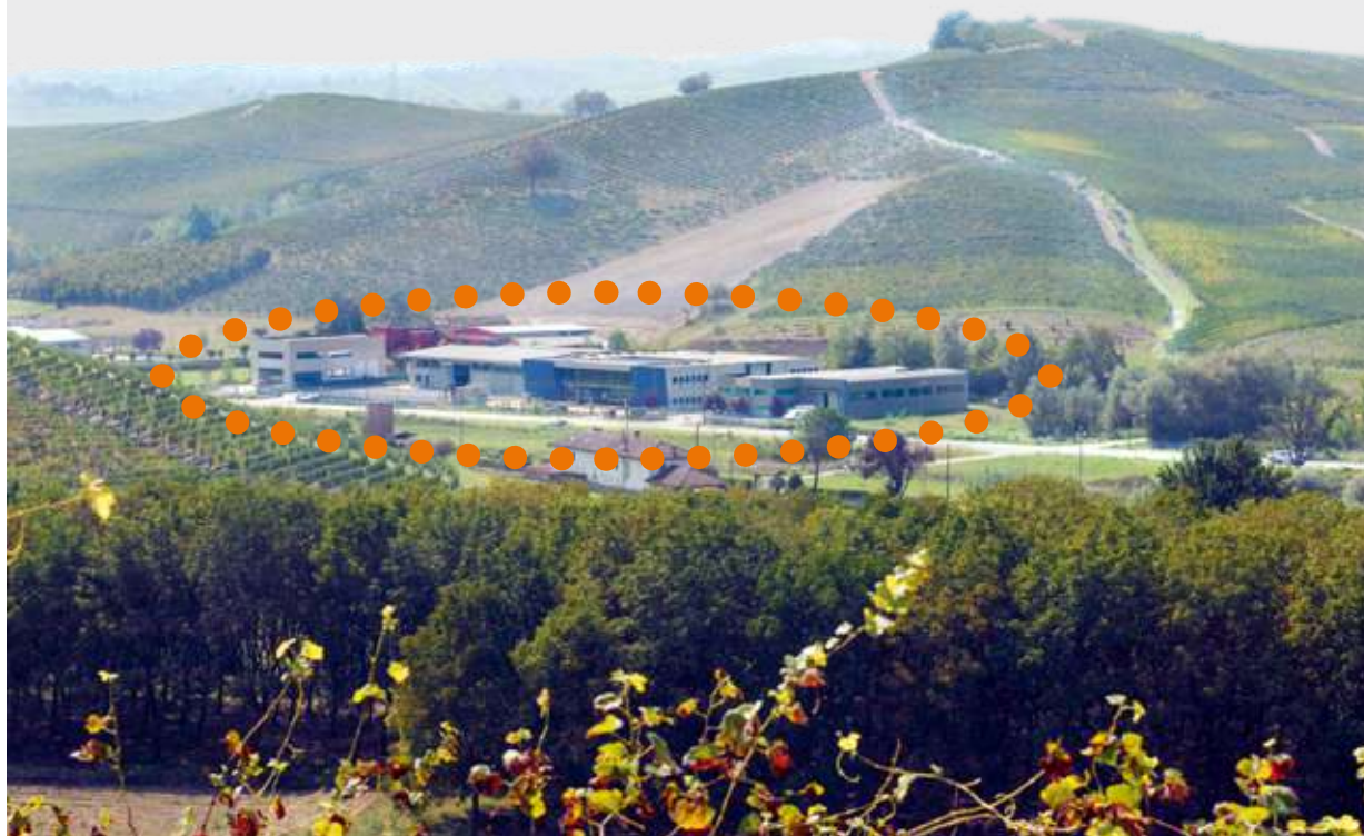
L'insediamento industriale di Agliano Terme visto dal Belvedere San Bernandno
