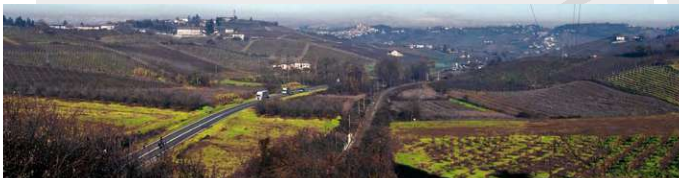
Dal Belvedere sopra la galleria in direzione di Asti
